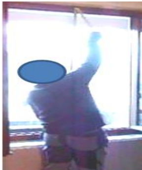
Travaux en extension
